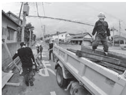
(岡山県真備町の被災地)
