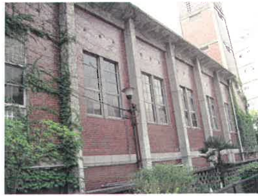
大聖堂外観 コンクリート支柱に防水化を施す
