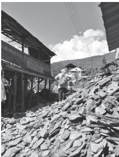
崩れ落ちた民家
