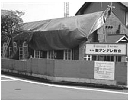
屋根工事中の聖堂
